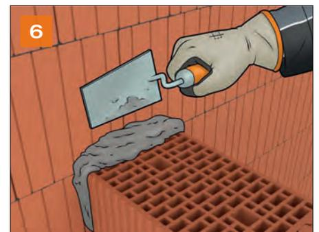
6 Beim Stumpfstoß Anschlussfuge satt vermörteln.
