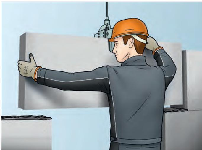
Versetzen eines Fertigteilsturzes in Mörtelbett
