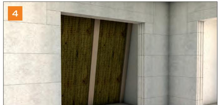
Flachsturz mit vermörtelten Stoßfugen in der Übermauerung.
