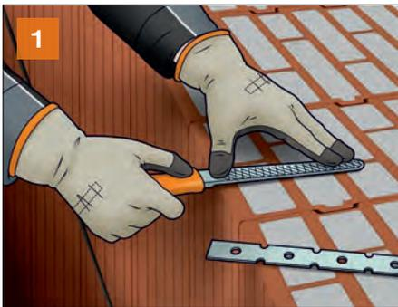
1 Vertiefen der Lagerfläche des Ziegels mit Keramikfeile, um Flachstahlanker in der Fuge zu versenken.
