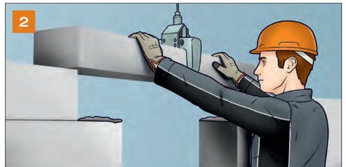
Einbau eines Flachsturzes mit Versetzhilfe.
