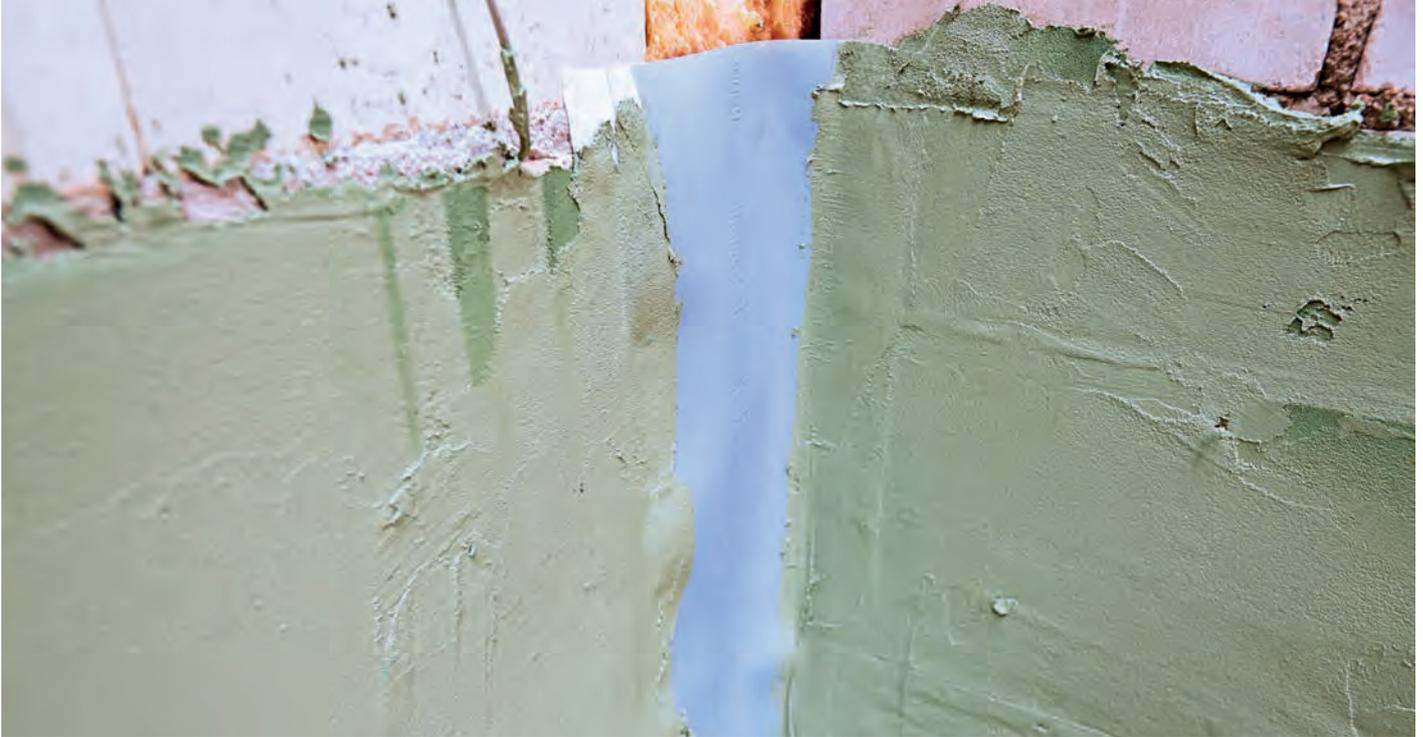
Bewegungs- oder Gebäudetrennfugen werden mit Fugenbändern aus Kunststoff mit Randvlies abgedichtet. Das Fugendichtband wird in die Flächenabdichtung eingearbeitet.
