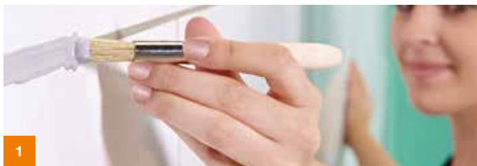
1 Reinigen Sie die Fläche, die Sie bearbeiten wollen. Entfernen Sie Verschmutzungen und Beschichtungen. Lassen Sie die Fugen trocknen. Tragen Sie dann den Fugenfärber mit einem Pinsel oder einer kleinen Bürste auf.
