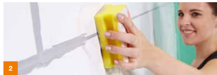
2 Wischen Sie Reste des Fugenfärbers mit einem speziellen Reinigungsschwamm von den Fliesen.
