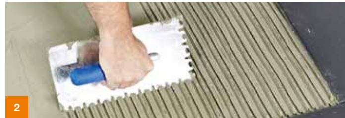
2 Tragen Sie den Kleber mit einem Zahnpachtel auf und kämten Sie ihn gut durch. Beginnen Sie mit einer kleinen Fläche, die für 3 bis 5 Fliesen ausreicht.
