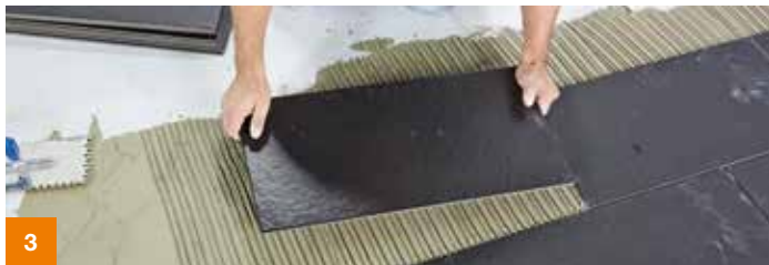
3 Fliese um Fliese wird nun in das Mörtelbett eingeschoben, ausgerichtet und angedrückt. Achten Sie dabei auf eine nahezu hohlraumfreie Verlegung: Die Fliese darf nie „knirschen“, also ohne genügend Mörtel, auf dem Untergrund aufliegen.
