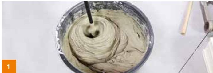
1 Rühren Sie den Fliesenkleber an. Folgen Sie den Anweisungen auf dem Sack.
