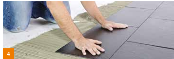
4 Mit Fugenkreuzen können Sie dafür sorgen, dass der Abstand zwischen den Fliesen immer gleich groß ist. Legen Sie bei Flächen über 20 m 2 Dehnungsfugen an!
