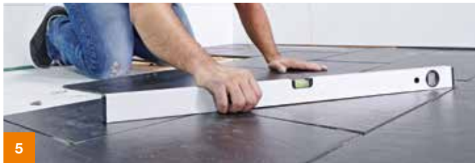
5 Prüfen Sie mit der Wasserwaage, ob die Fliesen plan liegen. Bringen Sie die Sockelleiste ganz zum Schluss an. Reinigen Sie die Fliesen sorgfältig mit einem feuchten Schwamm und entfernen Sie etwaige Mörtelreste aus den Fugen.
