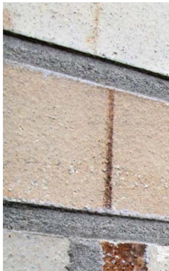
Der Mauerwerksverband prägt ganz entscheidend das optische Erscheinungsbild einer Verblendfassade. Für das Mauern mit genormten künstlichen Steinen nennt die DIN EN 1996-1 folgende Regeln: Mauersteine müssen im Verband mit Mörtel nach bewährten Regeln vermauert werden. Bei unbewehrtem Mauerwerk aus Mauersteinen mit einer Höhe  $\leq 250$  mm
