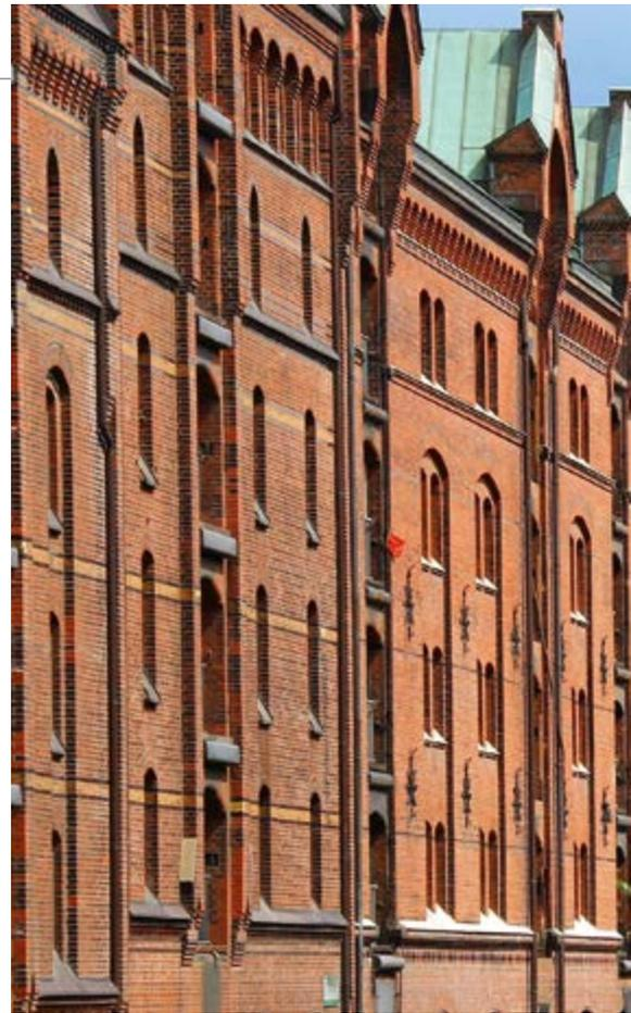
Viele ältere, historische und denkmalgeschützte Bauwerke zeigen, dass Fassaden aus Verblendmauerwerk eine fast unbegrenzte Lebensdauer haben. Jedoch sind die Fassaden durch die über viele Jahrzehnte andauernde Bewitterung hohen Belastungen ausgesetzt. Insbesondere eindringende Feuchtigkeit, Temperaturspannungen, Algen- und Moosbewuchs, aber auch Umweltverschmutzungen und Ähnliches führen dazu, dass Sanierungs- und Restaurierungsmaßnahmen an Verblendfassaden notwendig werden.
