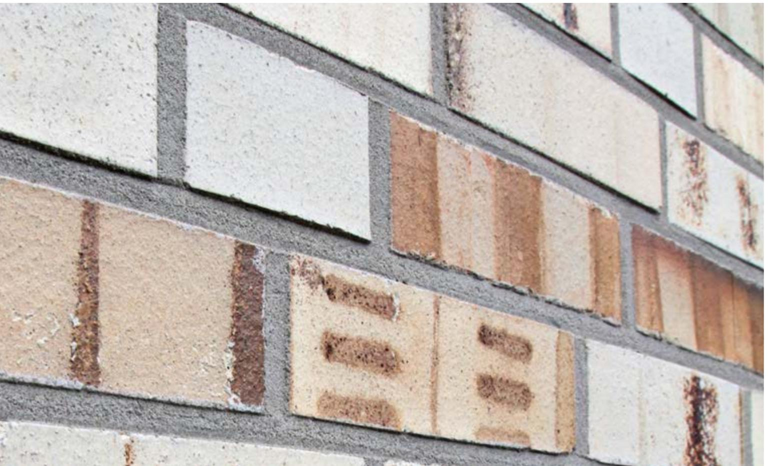
Bei der Mauerwerksherstellung mit V.O.R. Mauermörtel erfolgt das Aufmauern und Verfugen in einem Arbeitsgang. Dabei wird beim Mauern der Mörtel besonders satt aufgebracht. Der beim Aufsetzen des Verblendsteines aus den Fugen tretende Mörtel wird zunächst mit der Kelle abgestrichen. Nach dem Ansteifen des Mörtels
